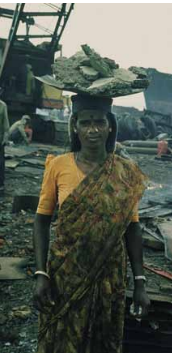
ASBEST blir ofte håndtert uten noen form for sikkerhetstiltak. FOTO: GREENPEACE
