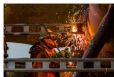
Hederlig omtale 2015 - Bjarne Hovland - KL Sandefjord - Arbeid på propellaksel KL Sandefjord - propellblader i bakgrunn
