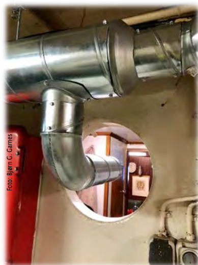
Uheldig skottgjennomføring i et køye
